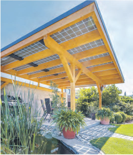
Sonnige Aussichten für die nächste Energierechnung: Ein Solarterrassendach macht unabhängiger von den öffentlichen Netzen. Foto: DJD/www.solarcarporte.de
